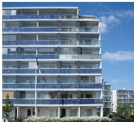
Նկար 3.2.12. Վիիկի՝ ցածր էներգածախսմամբ շենքերով թաղամաս Հելսինկիում (Ֆինլանդիա): Շենքի ճակատամասում ներկառուցված են վառարաններ, որոնք կուրակում են արևային էներգիան
