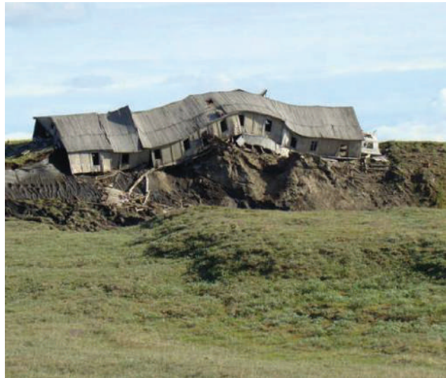
Նկար 2.8.9. Զորամասի քանդված շենքը գրունտի անհավասարաչափ ուռչելու և նստեցման հետևանքով
