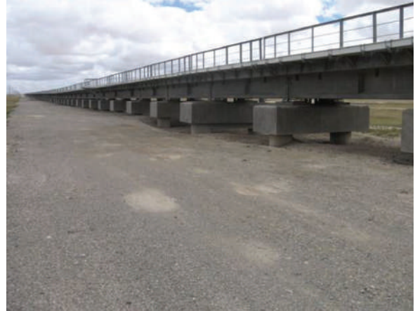
Նկար 2.8.14. Հողի մեջ խրված հալուկ հենարանների վրա կառուցված ճանապարհ
