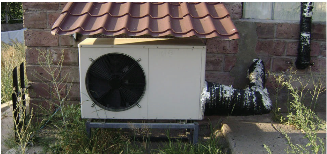
Նկար 3.1.12. Ջերմարան ջեռուցման համակարգ օդ-ջուր տիպի ջերմային պոմպի միջոցով ՀՀ Շիրակի մարզի Բասեն համայնքային մանկապարտեզում
