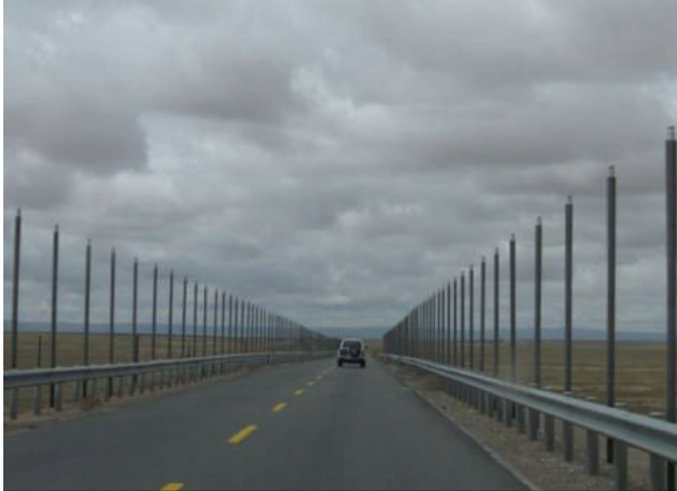
Նկար 2.8.13. Սառեցնող թերմոսիֆոններով ճանապարհ
