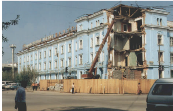
Նկար 2.8.11. Շենքի անկյունի փլուզում, ք. Յակուտսկի կենտրոն (Ռուսաստան)
